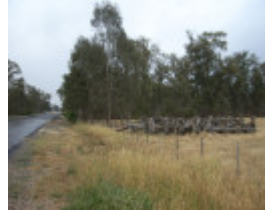
DANNS BRIDGE SOHE 2008
