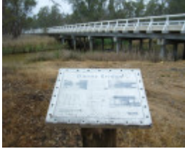
DANNS BRIDGE SOHE 2008
