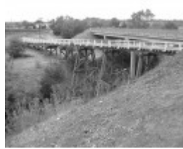
Site 012 - Trestle Bridhge - Arundel Road bridge.jpg
