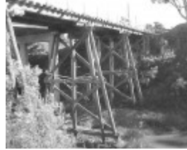
Site 012 - Arundel Road Trestle Bridge.jpg
