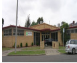
HO80 8 Watt St 1.JPG
