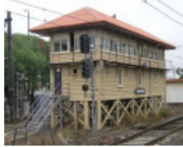
HO39 Sunshine Signal Box 2.JPG
