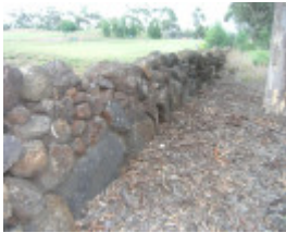
HO017 Derrimut Wall 3.JPG
