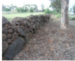
HO017 Derrimut Wall 2.JPG
