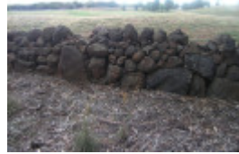
HO017 Derrimut Wall 1.JPG
