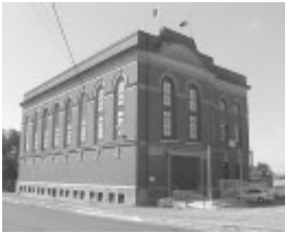
Site 003 - Albion VR, DC sub station.jpg
