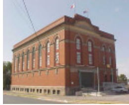
Site 003 - Albion VR, DC sub station (2).jpg
