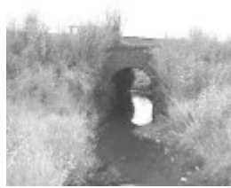
Site 028 - Railway culvet.jpg
