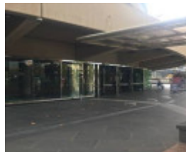
2019_Hamer Hall entrance.jpg
