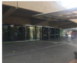
2019_Hamer Hall entrance.jpg
