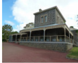
H0281 TARNDWARNCOORT HOMESTEAD LHA 2015 1.JPG
