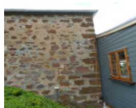
H0281 TARNDWARNCOORT HOMESTEAD LHA 2015 3.JPG
