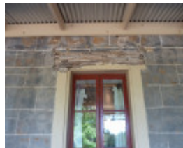
H0281 TARNDWARNCOORT HOMESTEAD LHA 2015 4.JPG
