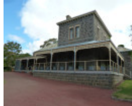
H0281 TARNDWARNCOORT HOMESTEAD LHA 2015 1.JPG
