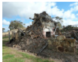
H0281 TARNDWARNCOORT HOMESTEAD LHA 2015 6.JPG
