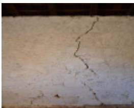
H0281 TARNDWARNCOORT HOMESTEAD LHA 2015 5.JPG
