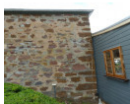
H0281 TARNDWARNCOORT HOMESTEAD LHA 2015 3.JPG
