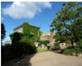
H0281 TARNDWARNCOORT HOMESTEAD LHA 2015 2.JPG
