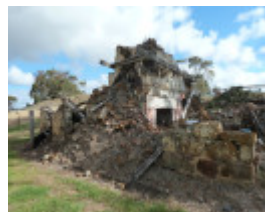
H0281 TARNDWARNCOORT HOMESTEAD LHA 2015 6.JPG
