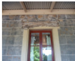
H0281 TARNDWARNCOORT HOMESTEAD LHA 2015 4.JPG
