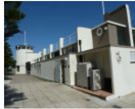
H0927 DRESSING PAVILION LHA 2015 2.JPG
