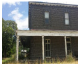
Ingleby Southern Elevation 2016.jpg
