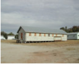
Storehouse (Blanket Store)
