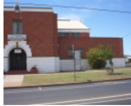
Mildura Drill Hall 3.jpg
