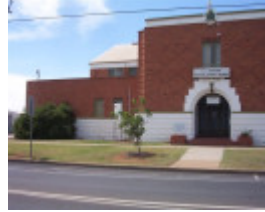
Mildura Drill Hall 1.jpg
