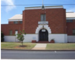
Mildura Drill Hall 2.jpg
