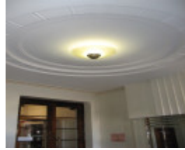
2011_mar_2_Horsham Town Hall (27).jpg
