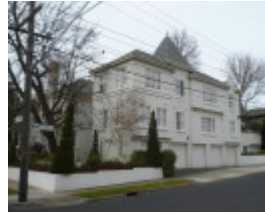
Gradsden Hall Flats
