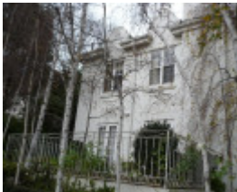
Gradsden Hall Flats
