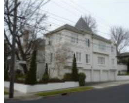
Gradsden Hall Flats
