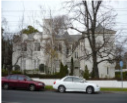
Gradsden Hall Flats
