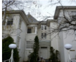
Gradsden Hall Flats
