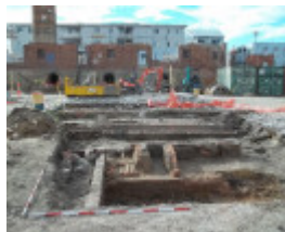
Excavation images 15- 18 Aug 11.jpg
