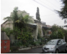
IMG_1353 18 Park Ave.JPG
