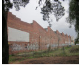
IMG_1231 224 Heidelberg Rd.JPG
