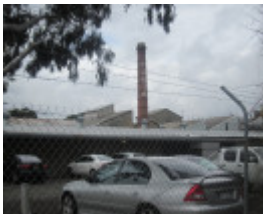
IMG_1235 224 Heidelberg Rd.JPG
