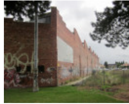
IMG_1230 224 Heidelberg Rd.JPG
