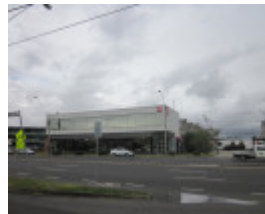
IMG_1236 224 Heidelberg Rd.JPG
