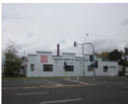
IMG_1238 224 Heidelberg Rd.JPG
