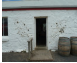
H1222 CAPE OTWAY LIGHTSTATION LHA 2015 4.JPG
