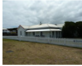
H1222 CAPE OTWAY LIGHTSTATION LHA 2015 3.JPG
