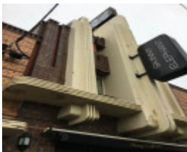
2017 1928 facade detail fins 2.jpg
