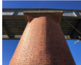
2018 top of 1896 pier.jpg
