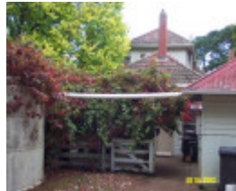
23230 Dunroe Byaduk North garage 0052
