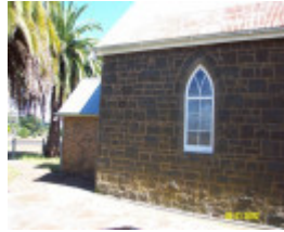
23270 Uniting Ch Byaduk side elevation 0373
