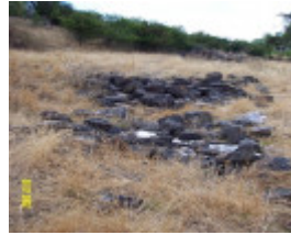
23274 Holmes Flour Mill Byaduk 0381
