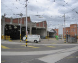
Essendon Tram Depot.JPG
