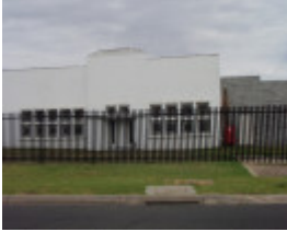
HO17 - F.T.Wimble & Co, 13-21 Annesley Street, Braybrook.JPG
