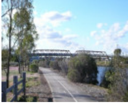
HO146(1) - Angliss Stock Bridge 1.jpg
