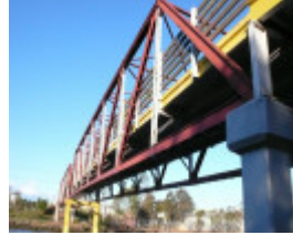
HO146(2) - Angliss Stock Bridge 2.jpg
