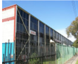
HO83(3) - Eta Factory, 254 Ballarat Road, Braybrook.JPG
