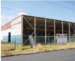
HO83(1) - Eta Factory, 254 Ballarat Road, Braybrook.JPG
