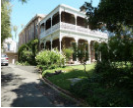
1104 Malvern Rd, Armadale
