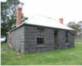
206175_Redesdaile_Kyneton Redesdaile Road_2306 img01
