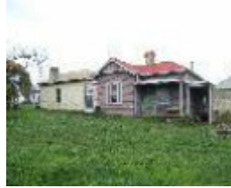
206184_Redesdale_Kyneton Redesdale Road_2351 img05
