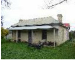
206184_Redesdale_Kyneton Redesdale Road_2351 img02
