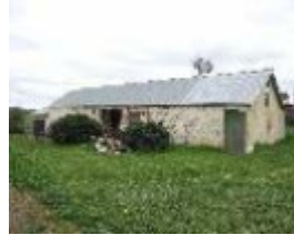
206184_Redesdale_Kyneton Redesdale Road_2351 img21
