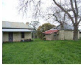
206184_Redesdale_Kyneton Redesdale Road_2351 img01
