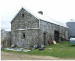
206170_Redesdale_Kyneton Redesdale Road_2406 img01
