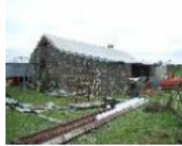
206170_Redesdale_Kyneton Redesdale Road_2406 img09
