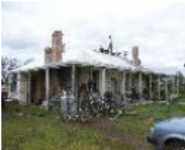
206170_Redesdale_Kyneton Redesdale Road_2406 img18
