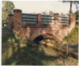
HO2 Pipe 8.jpg
