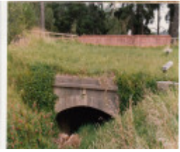
HO2 Pipe 9.jpg
