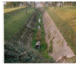
HO2 Pipe 10.jpg
