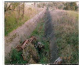
HO2 Pipe 11.jpg
