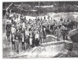
HO2 Pipe Opening.jpg
