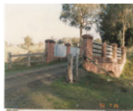
HO2 Pipe 7.jpg
