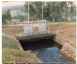
HO2 Pipe 2.jpg
