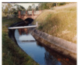
HO2 Pipe 5.jpg
