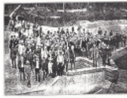
HO2 Pipe Opening.jpg
