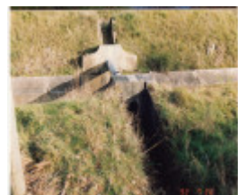
HO2 Pipe 6.jpg
