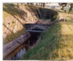
HO2 Pipe 4.jpg
