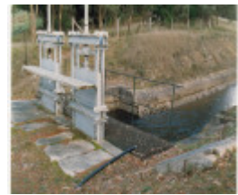
HO2 Pipe 3.jpg
