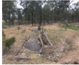
2017_Collapsed latrine pits_F8.jpg
