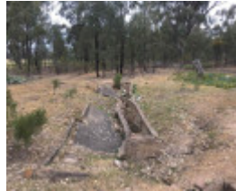
2017_Collapsed latrine pits_F8.jpg
