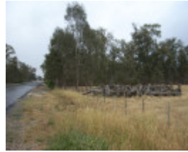
DANNS BRIDGE SOHE 2008
