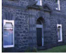
d'estaville kew detail of stone entrance
