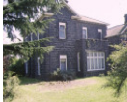
1 d'estaville kew view of house
