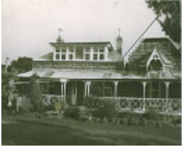
B2905 Bleak House Birregurra
