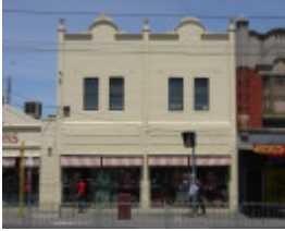
Bridge Rd 490-492.JPG
