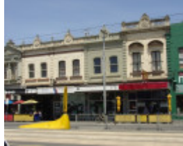
Bridge Rd 376-382.JPG
