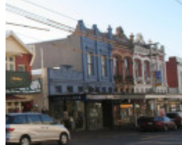
Bridge Rd 4103.JPG
