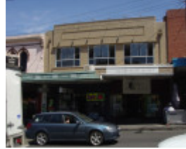
Bridge Rd 204-206.JPG
