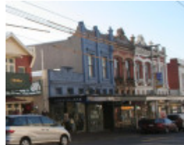
Bridge Rd 4103.JPG
