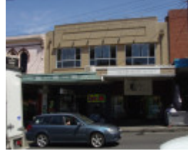
Bridge Rd 204-206.JPG
