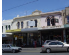
Bridge Rd 208-212.JPG
