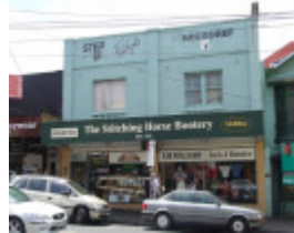
Bridge Rd 191-193.JPG
