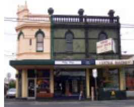
Bridge Rd 2776.JPG
