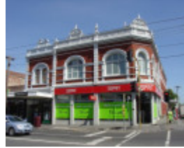
Bridge Rd 132-134.JPG
