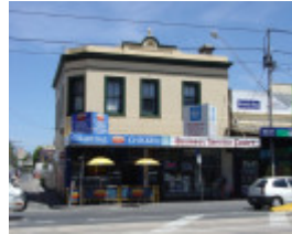
Bridge Rd 310-312.JPG
