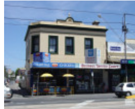
Bridge Rd 310-312.JPG
