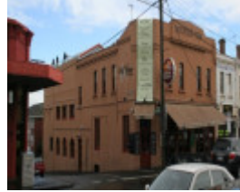
Bridge Rd 68-70 10203.JPG
